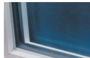
DuraLite Warm Edge Spacer = no condensation
